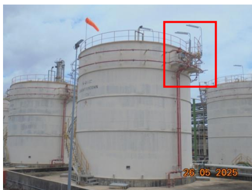
รูปที่ 3.2-70 ระบบโคมของถังเก็บกักสารเคมี
