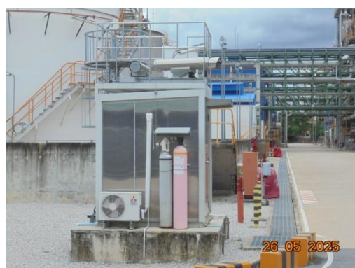
รูปที่ 3.2-73 Open Path Gas Detection
