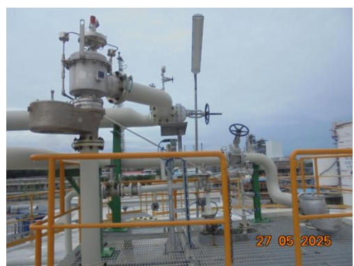
รูปที่ 3.2-65 วาล์วนิรภัยที่ถังเก็บกักสารเคมี
