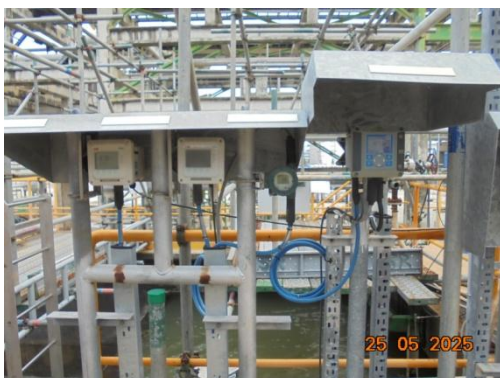
รูปที่ 3.2-36 เครื่องตรวจวัดคุณภาพน้ำทิ้ง แบบอัตโนมัติ ที่บ่อพักน้ำทิ้ง (Final Polishing Pond : TK-9141)
