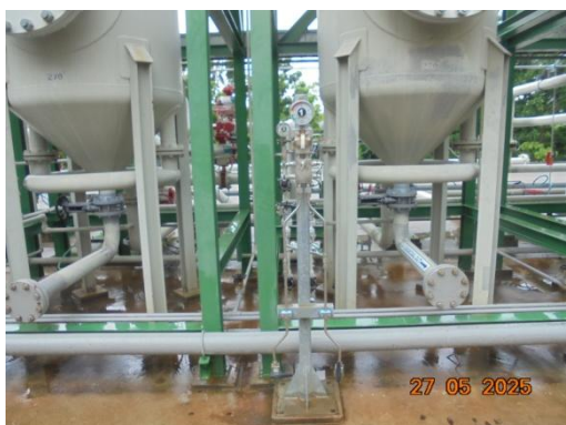
รูปที่ 3.2-9 เครื่องตรวจวัดความดันที่ทางเข้า-ออกของ Charcoal Adsorber
