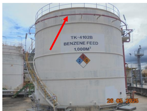
รูปที่ 3.2-78 ระบบ Water Spray ที่ถังเก็บสารเคมี
