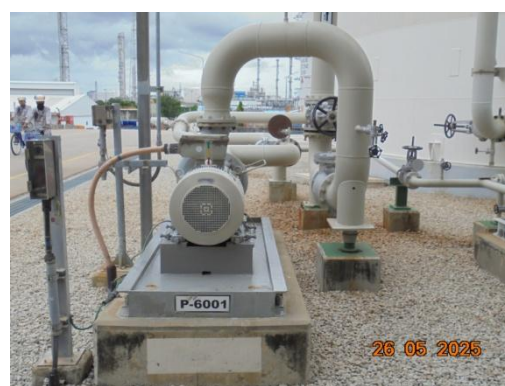
รูปที่ 3.2-12 เครื่องสูบน้ำสำรอง สำหรับระบบน้ำที่จ่ายน้ำให้ Scrubber
