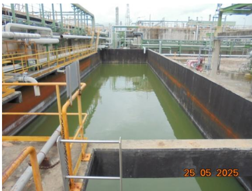
รูปที่ 3.2-34 บ่อพักน้ำทิ้งถูกเดิน (Diversion Basin : TK-9142A/B)
