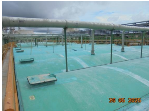
รูปที่ 3.2-38 ฝาปิดระบบบำบัดน้ำเสีย
