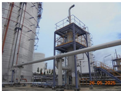
รูปที่ 3.2-10 ระบบดักจับไอระเหยด้วยน้ำ (Phenol Wet Scrubber) ของถังเก็บสารฟีนอล (TK-4162A/B)
