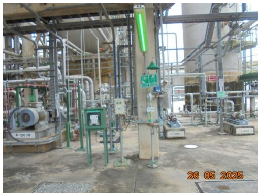
รูปที่ 3.2-82 อ่างล้างตาและร่างกายฉุกเฉิน
