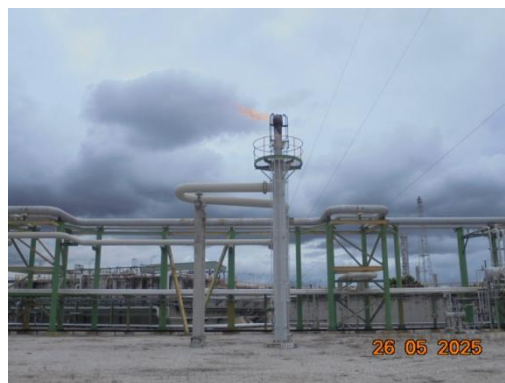
รูปที่ 3.2-6 หอเผาแบบความดันต่ำ (Low Pressure Flare)
