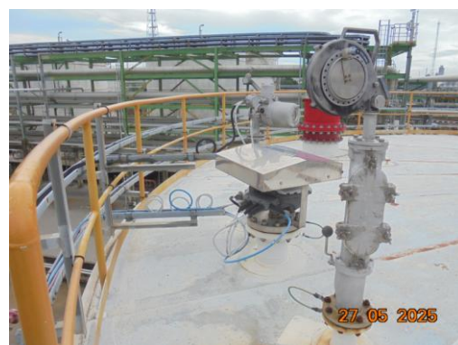
รูปที่ 3.2-75 Pressure/Vacuum Vent Valve
