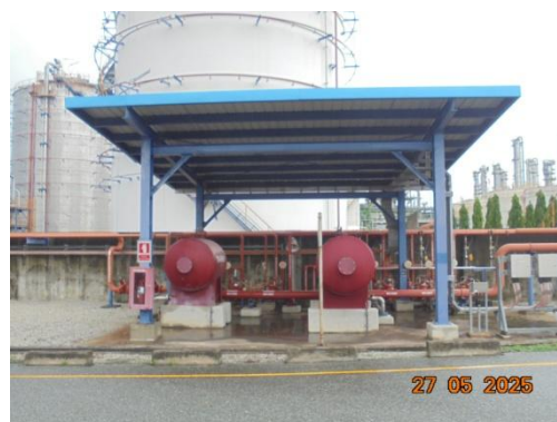
รูปที่ 3.2-79 ระบบดับเพลิงบริเวณถังเก็บกักอะซิโตน
