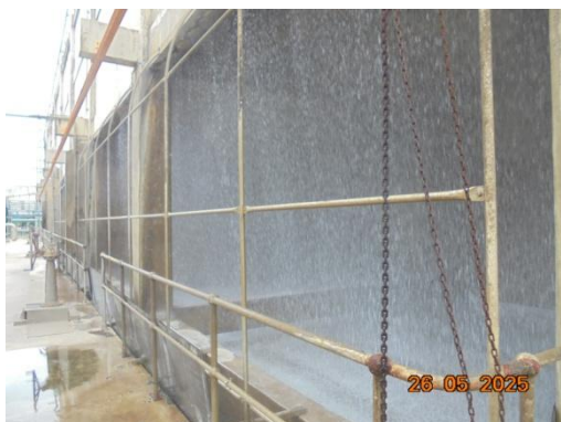
รูปที่ 3.2-23 แผ่นกันเสียงที่หอหล่อเย็น
