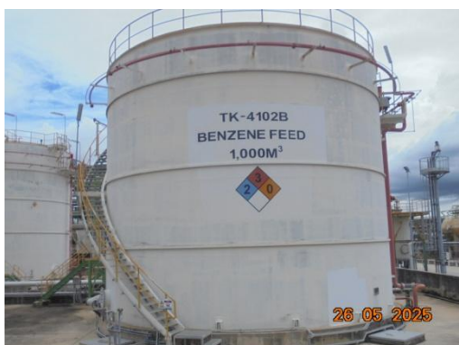
รูปที่ 3.2-74 ถังเก็บกักเบนซีน
