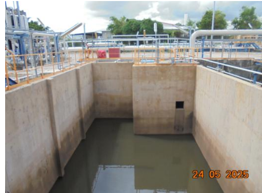
รูปที่ 3.2-33 บ่อพักน้ำฝนปนเปื้อนในพื้นที่โครงการ โรงงานผลิตสารฟีนอล เอ
