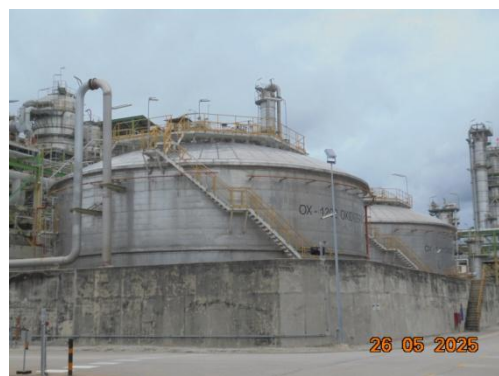
รูปที่ 3.2-71 คันคอนกรีตบริเวณที่เก็บกักวัตถุดิบ และผลิตภัณฑ์
