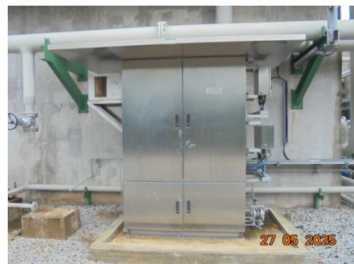
รูปที่ 3.2-37 เครื่องตรวจวัด COD แบบอัตโนมัติ ที่ Final Polishing Buffer Tank (TK-9145)
