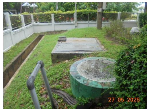
รูปที่ 3.2-41 บ่อตรวจสอบคุณภาพน้ำทิ้ง จากสำนักงานและโรงอาหาร
