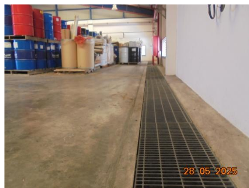
รูปที่ 3.2-59 รางระบายน้ำในอาคารเก็บของเสีย
