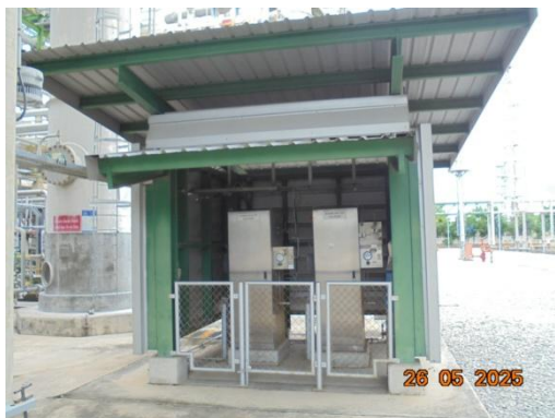
รูปที่ 3.2-7 เครื่องตรวจวัดเบนซีนแบบต่อเนื่อง ที่ปล่อง Charcoal Adsorber 2
