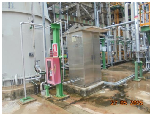
รูปที่ 3.2-8 เครื่องตรวจวัดสารประกอบ ไฮโดรคาร์บอนแบบต่อเนื่อง ที่ปล่อง Charcoal Adsorber 6
