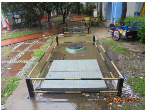
รูปที่ 3.2-40 ระบบบำบัดน้ำเสียแบบไร้อากาศ และเติมอากาศแบบสำเร็จรูป
