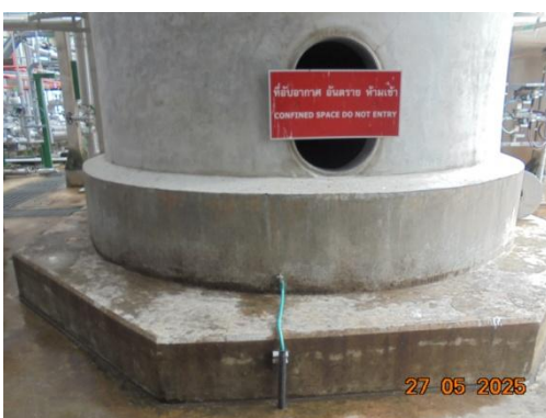
รูปที่ 3.2-66 ระบบสายดินที่ถังเก็บกักสารเคมี
