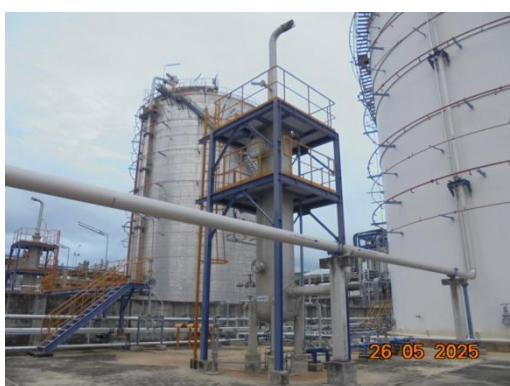
รูปที่ 3.2-11 ระบบดักจับไอระเหยด้วยน้ำ (Acetone Wet Scrubber) ของถังเก็บสารอะซิโตน (TK-4163A/B)
