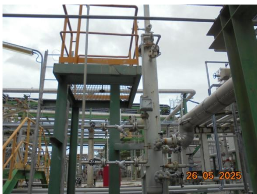
รูปที่ 3.2-13 อุปกรณ์ตรวจวัดอัตราการไหล ของน้ำที่เข้าสู่ Scrubber
