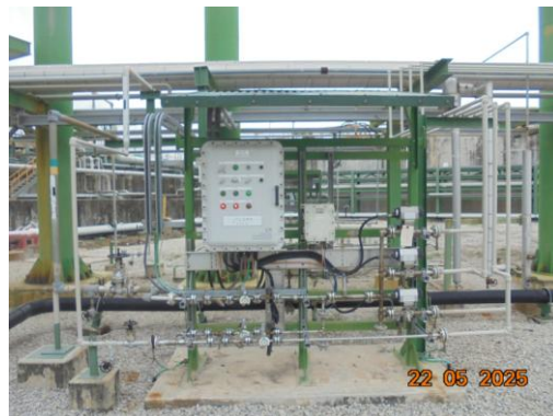
รูปที่ 3.2-20 ระบบไฟฟ้าสำรองจาก UPS สำหรับระบบจุดไฟ Flare Pilot อัตโนมัติ
