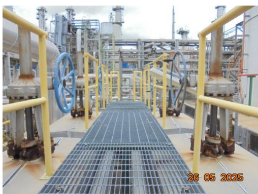
รูปที่ 3.2-72 ระบบท่อเชื่อมสำหรับขนถ่าย ไนโตรเจน
