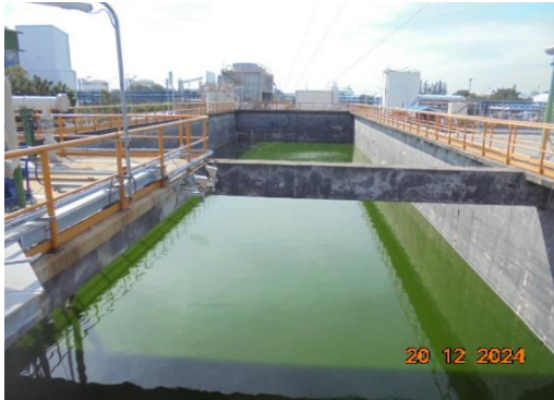
รูปที่ 3.2-32 บ่อพักน้ำฝนปนเปื้อน
